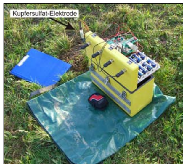
Abb. 5: Datenlogger Geolore im Unterwassergehäuse, im Hintergrund eine Cu/CuSO 4 -Elektrode.
